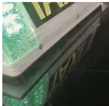
Figura 4. Vistas de la protección con silicona en todo el perímetro de la placa
