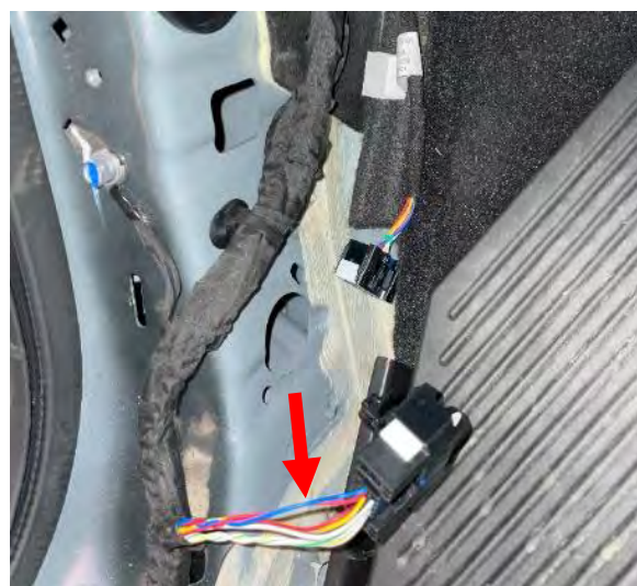
Figura 3.3.1.9: Cables sobre los que tomar la señal
