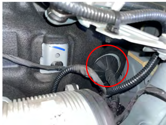
Figura 4.2.6.20: Vista del pasamuros desde el compartimento motor
