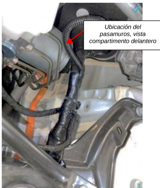
Fig. 3.4.3.6. Vista pasamuros lado motor
