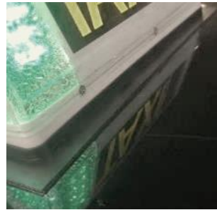
Figura 4.2.4.7. Vistas de la protección con silicona en todo el perímetro de la placa
