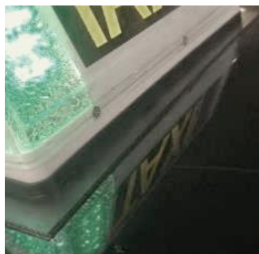
Figura 4.2.4.7. Vistas de la protección con silicona en todo el perímetro de la placa
