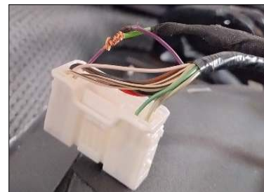
4. Soldar cable taxímetro a la señal de velocidad
