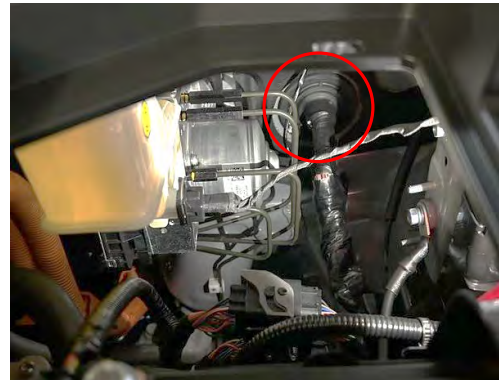
Figura 4.2.6.13: Vista del pasamuros desde la tapa de la batería
