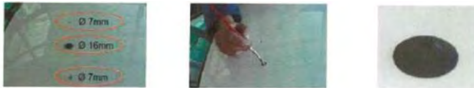
Figura 4.2.6.6: Preparación de los agujeros para el módulo tarifario atornillado
