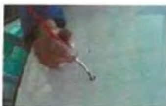
Figura 4.2.6.6: Preparación de los agujeros para el módulo tarifario atornillado
