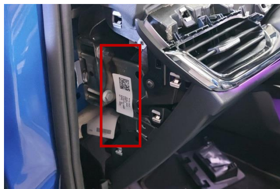
Figura 4. Ubicación caja de conexiones.
