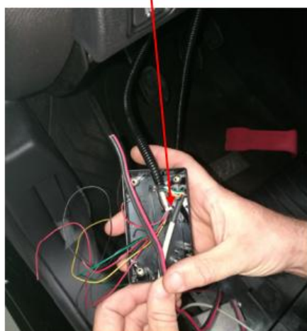
Conexiones caja adaptadora de señal
