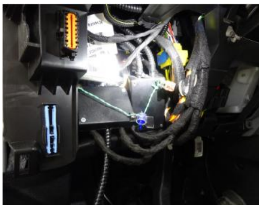
Precintado de la caja adaptadora de señal
