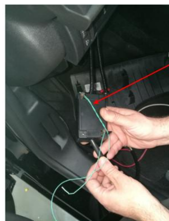
Precintado caja adaptadora de señal
