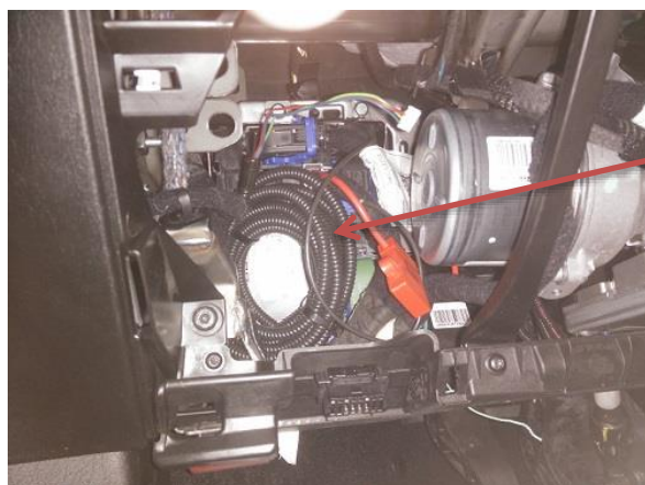
Manguera blindada Tubo corrugado de la instalación
