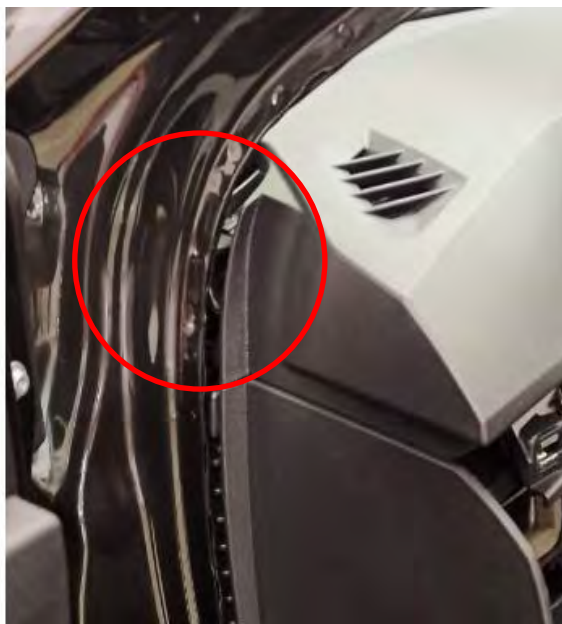
Fig. 4.6. Zona de paso del cableado
