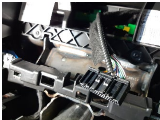
Fig. 2.2. Detalle paso de manguera blindada a la zona posterior del cuadro desde el conector 247
