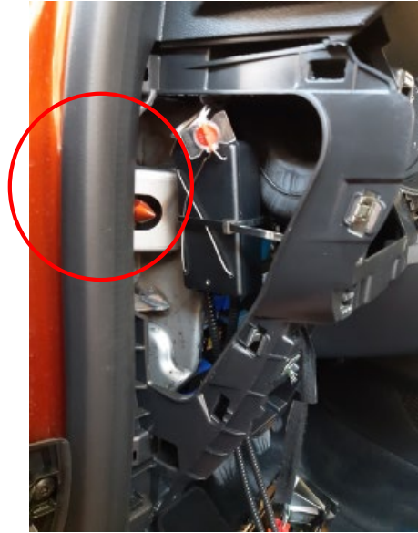
Fig. 4.6. Zona de paso del cableado
