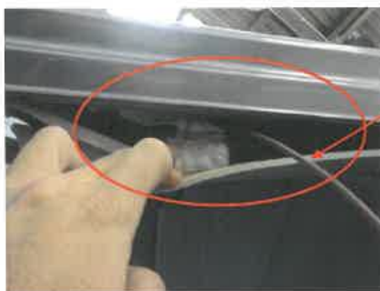
Cable módulo tarifario
