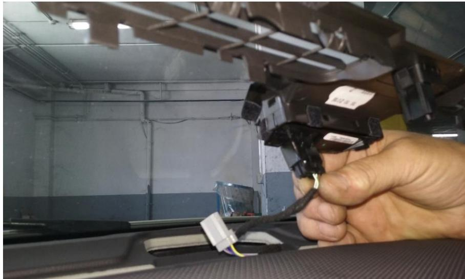
Por el hueco de dicha rejilla se hará pasar una guía rígida flexible para el paso de los cables por la zona interior del salpicadero hasta la zona inferior de la columna de dirección al encuentro de la preinstalación del fabricante.
