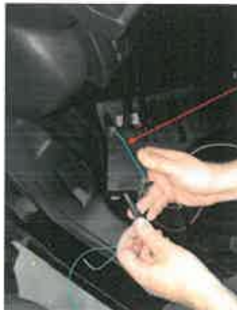
Precintado caja adaptadora de señal
