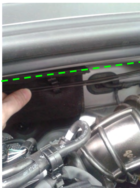
Fig. 6.6. Vista del paso de la manguera por el compartimento motor hacia el pasamuros
