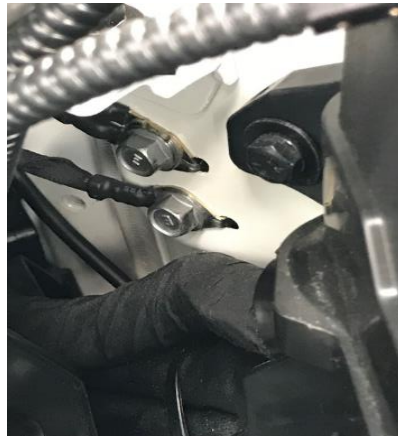
Fig. 2.2. Vista de las conexiones de alimentación.
