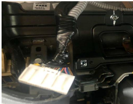
Fig. 1.4. Detalle del montaje final de la toma de señal y paso de manguera blindada por detrás del cuadro.
