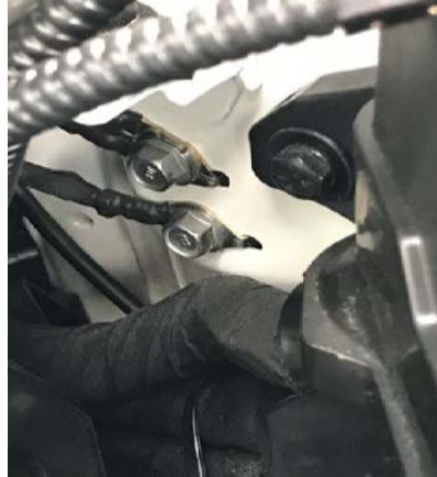
Fig. 2.2. Vista de las conexiones de alimentación.
