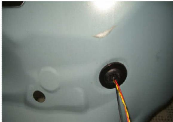
Figura 15 Tapa de cierre con pasamuros e instalación eléctrica incorporada en la pared frontal (visión exterior)
