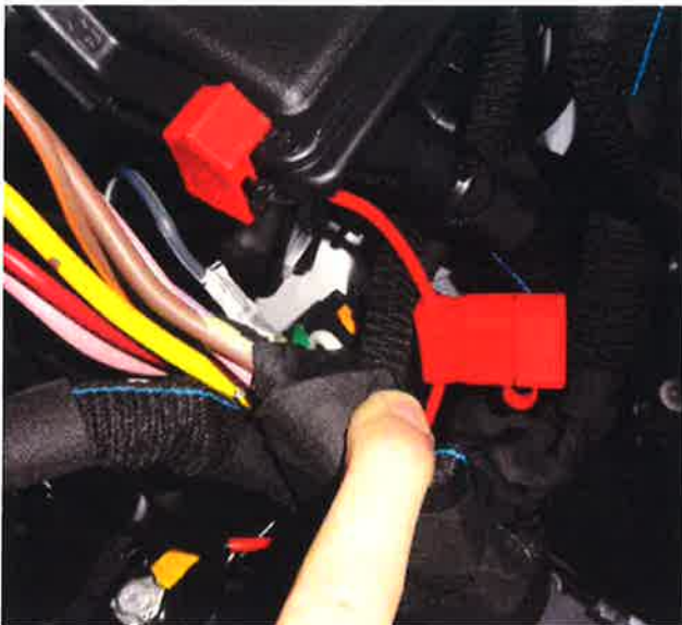
Fig. 4.3. Fotografía del cable de alimentación conectado a la caja de fusibles del vehículo.
