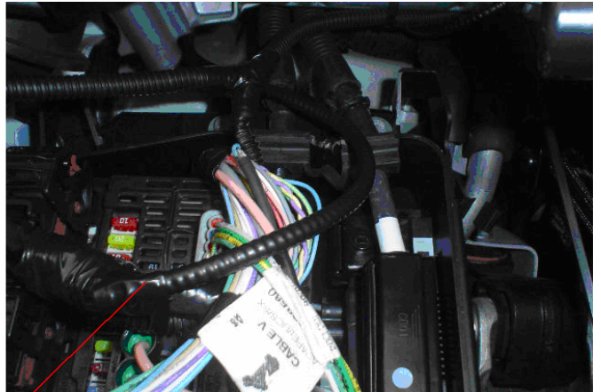
Manguera de alimentación para el captador
