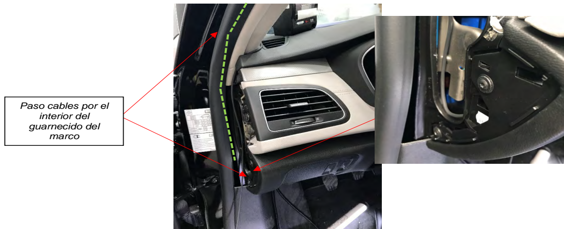
Fig. 4.5. Paso de cables para taxímetro de espejo.
