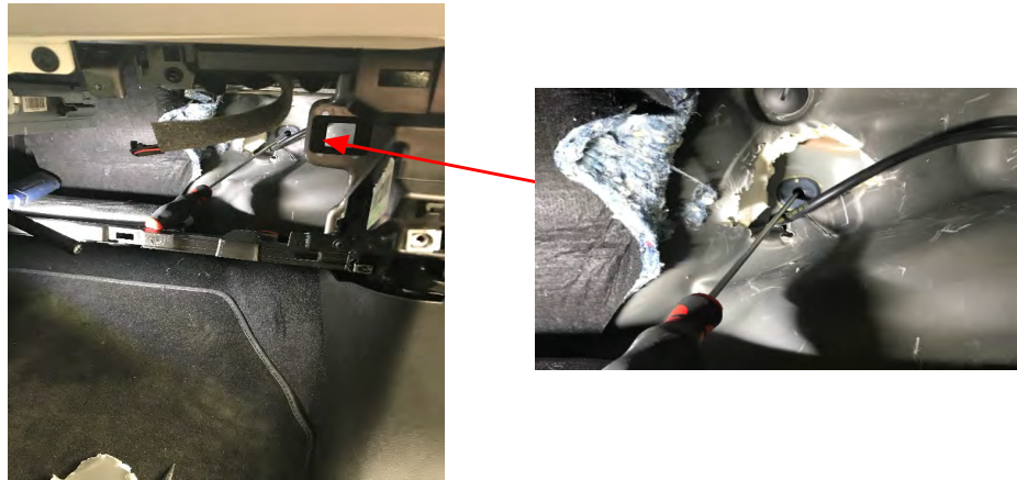
Fig. 2.2. Detalle paso cable de señal, detrás de la zona de la guantera, vista habitáculo
