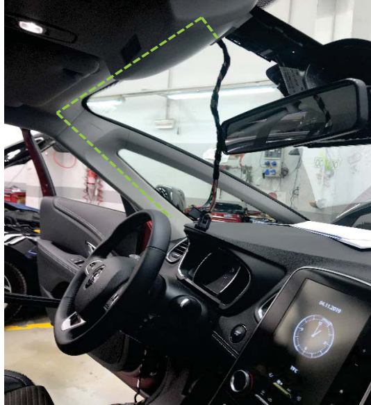
Fig. 4.4. Recorrido de los cables por el interior del guarnecido del techo
