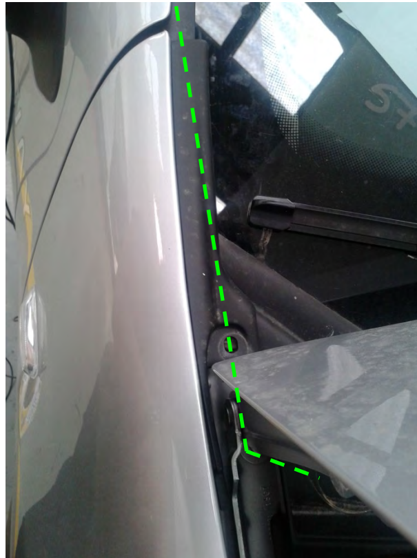
Fig. 10.2.2. Vista del paso de la manguera al compartimento motor
