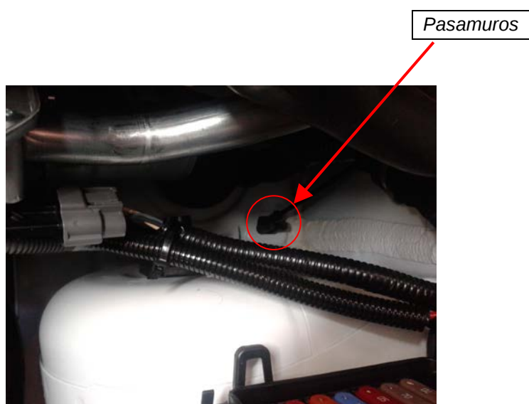
Fig. 1.3. Vista de la ubicación del pasamuros.
