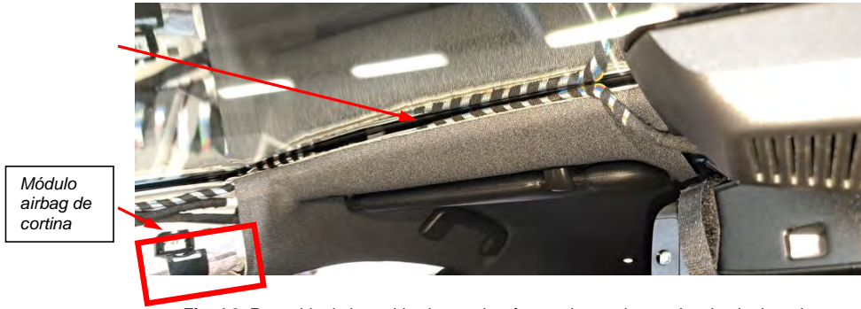
Fig. 4.3. Recorrido de los cables hasta el taxímetro de espejo por el tapizado de techo.
