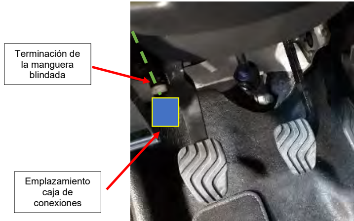
Fig. 3.1.1. Vista de la terminación de la manguera blindada puesta por el concesionario
