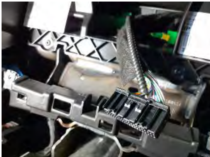
Fig. 2.1.3. Detalle paso de manguera blindada a la zona posterior del cuadro desde el conector 247
