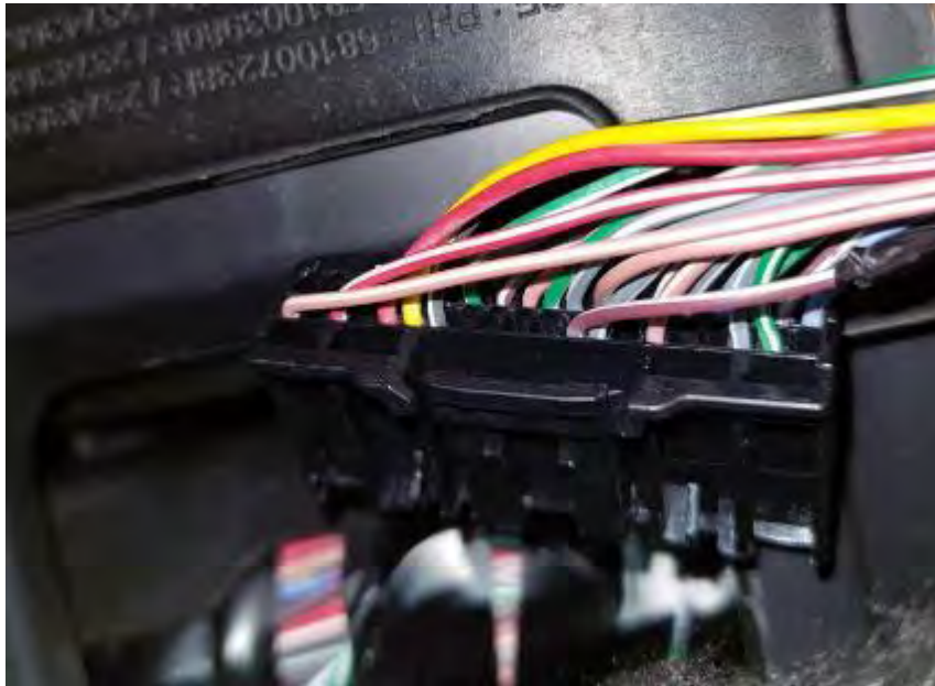
Fig. 1.3. Vista del conector 247 del cuadro de instrumentos
