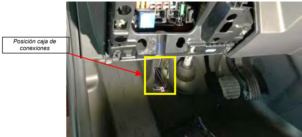
Fig. 3.3.4. Vista del de la caja de conexiones precintada e instalada con cinta de doble cara a la derecha del reposapiés.
