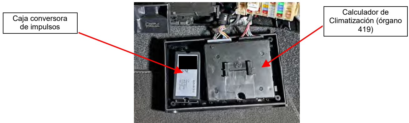
Fig.2.2.1. Caja contenedora de calculador de Climatización (órgano 419) y caja convertora de impulsos
