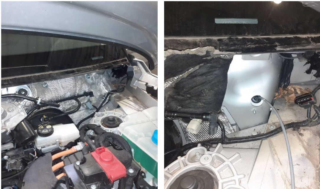
Fig. 1.11 y 1.12. Vistas de la ubicación del pasamuros, lado motor.
