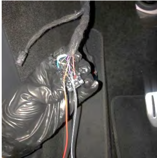
Vista de las conexiones de cables de señal sobre el conector X181
