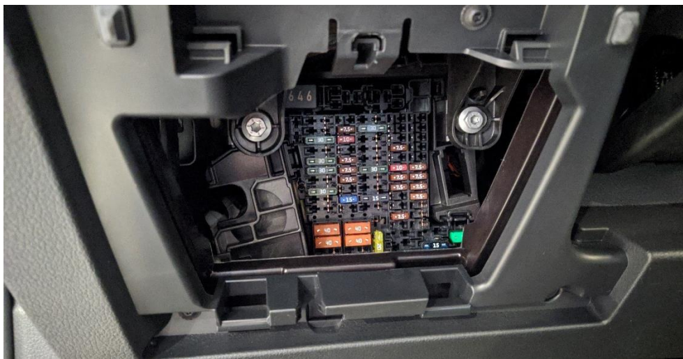
Figura 2. Caja de fusibles.
