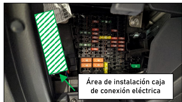
Figura 4. Área de instalación caja conexión eléctrica.
