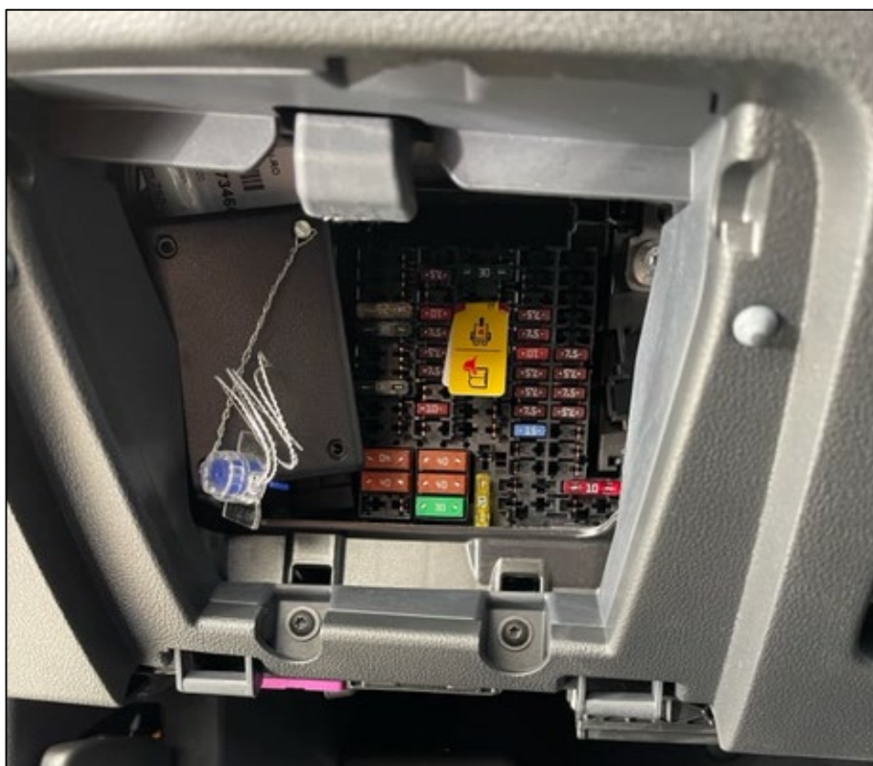
Figura 19. Precinto caja de conexiones. (Taller instalador)
