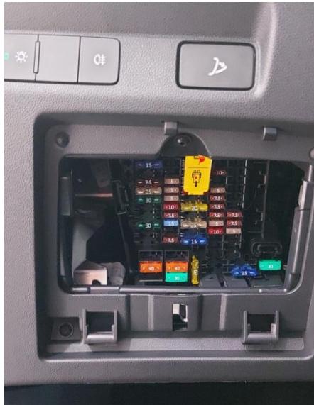
Figura 2. Caja de fusibles.
