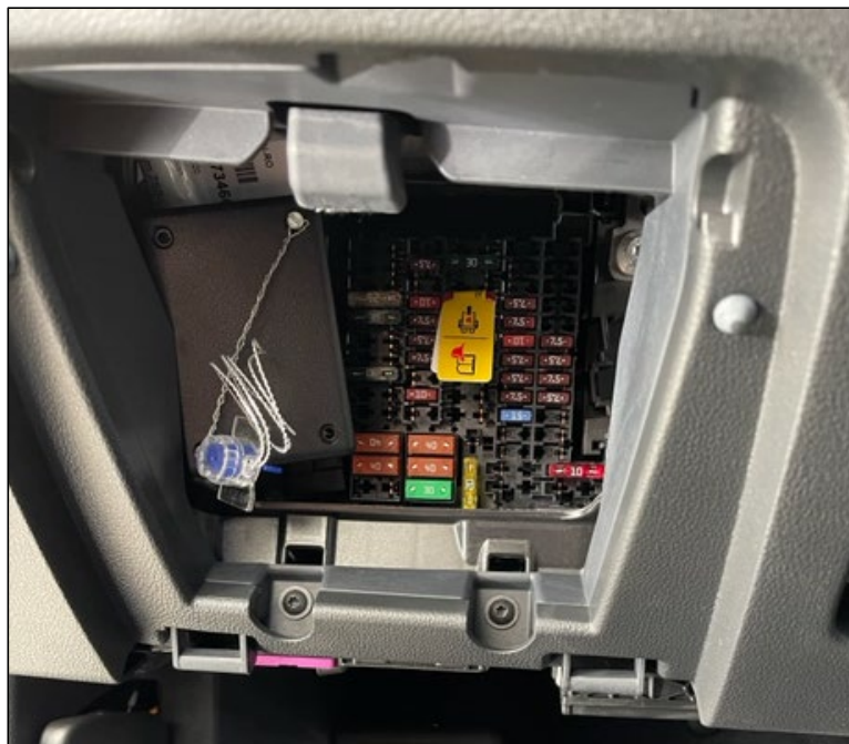
Figura 19. Precinto caja de conexiones. (Taller instalador)
