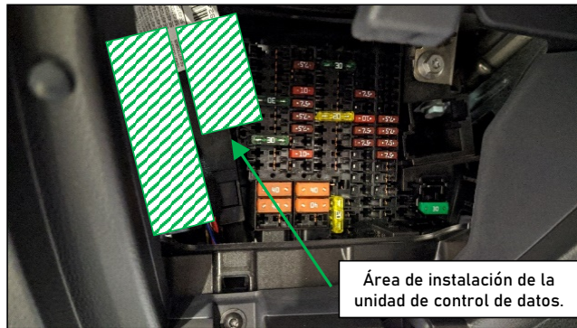
Figura 34. Área de instalación de la unidad de control de datos.
