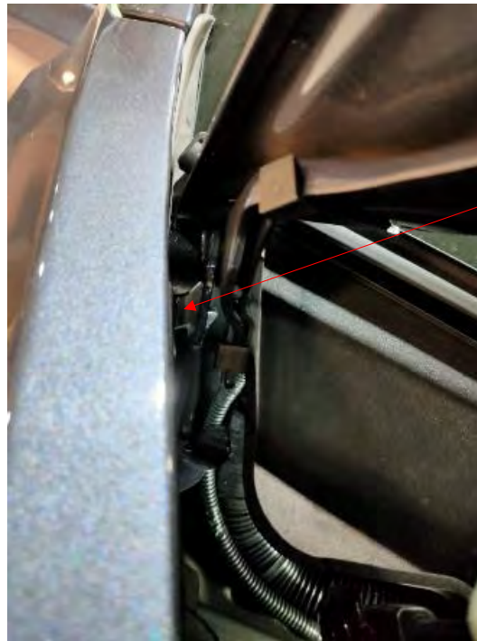
Paso del cable del módulo
