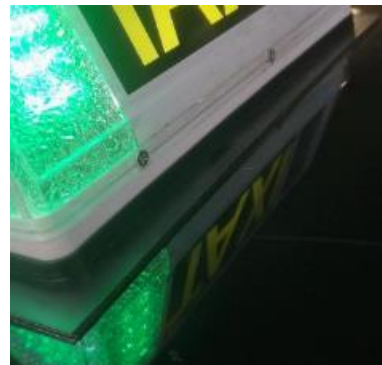
Vistas de la protección con silicona del perímetro de la placa.
