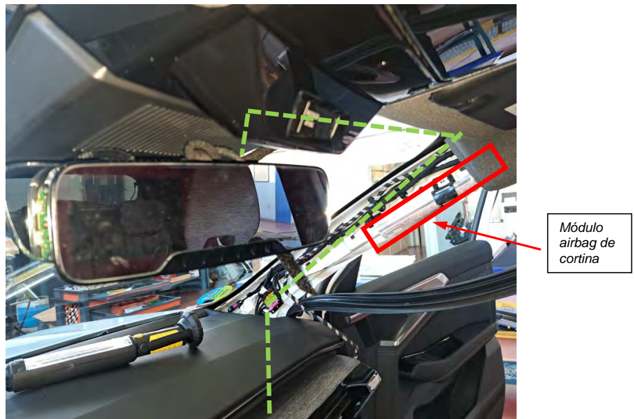
Fig. 4.2. Recorrido de los cables por el interior pilar A derecho.
