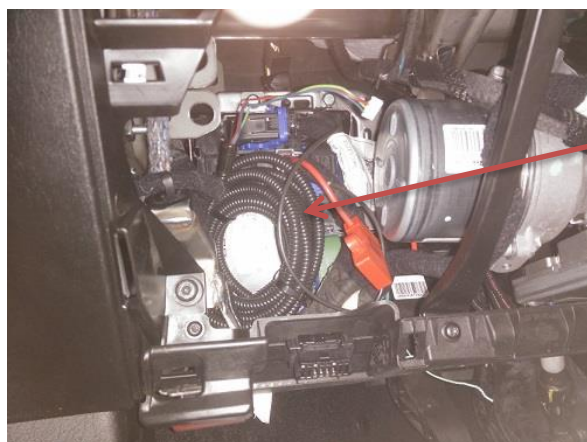
Manguera blindada Tubo corrugado de la instalación
