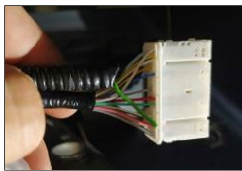
4. Soldar cable taxímetro a la señal de velocidad
