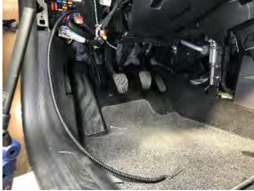
Fig. 3.1.1. Vista de la terminación de la manguera blindada puesta por el concesionario
