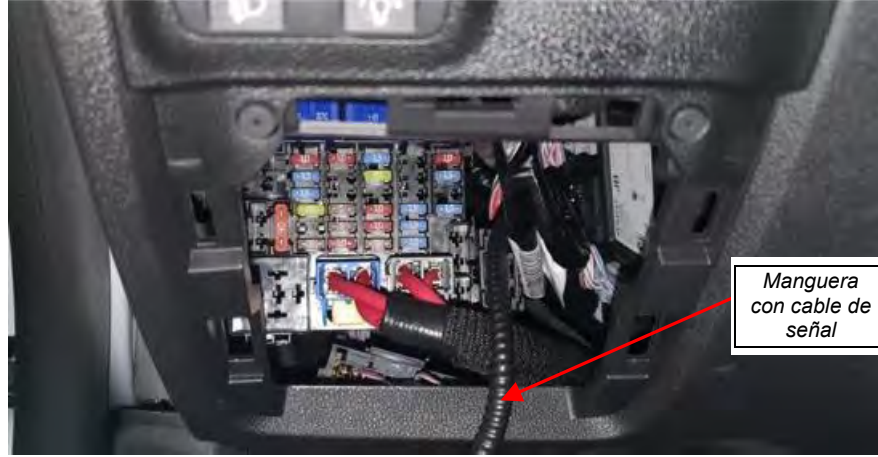
Fig. 2.1.4. Detalle del extremo de manguera en la caja de fusibles.
