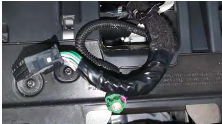
Fig. 2.2.3. Detalle conexión cable y paso manguera blindada por el cuadro.
