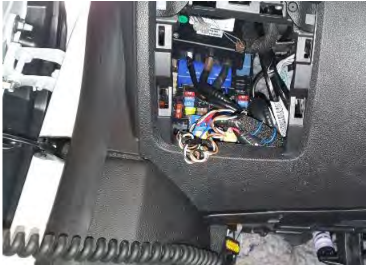
Fig. 3.3. Vista del montaje final de la caja adaptadora en el compartimento de la caja de fusibles.
