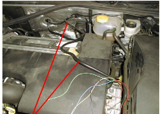
Paso de mangueras desde caja adaptadora de señal a taxímetro, y manguera desde batería a taxímetro
