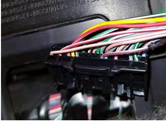
Fig. 1.5. Vista del conector 247 del cuadro de instrumentos
