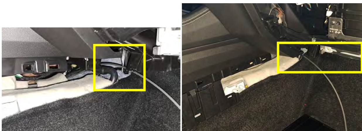
Fig. 2.4. Zona del paso de cables lado del pasajero
