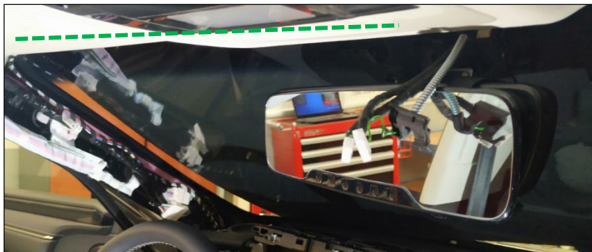
Ejemplo recorrido del cable del módulo tarifario
