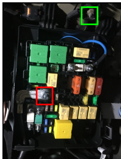
Caja fusibles tipo 2
