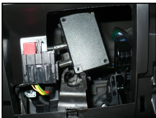
Caja de señales en la cubierta inferior bajo volante
