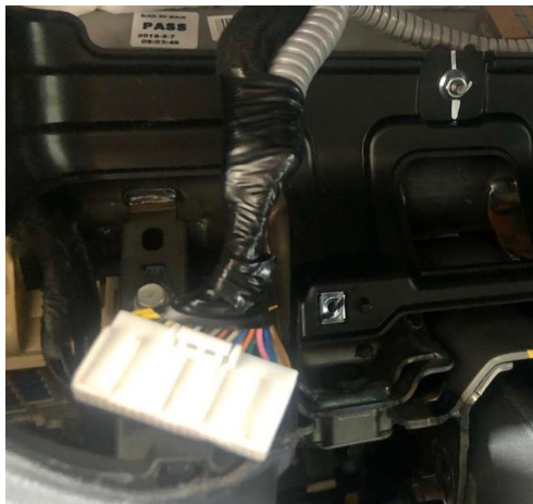
Fig. 1.5. Detalle del montaje final de la toma de señal y paso de manguera blindada por detrás del cuadro.
