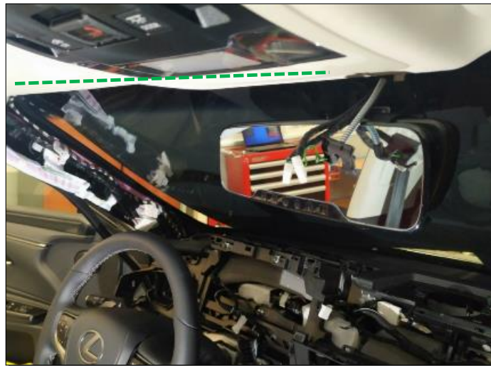
Recorrido del cable del módulo tarifario
