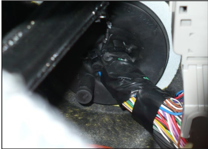
Sacar los cables por la parte exterior del pasamuros
