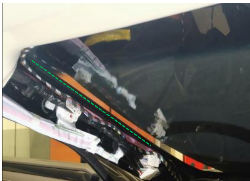
Vista interior lado lateral izquierdo delantero
